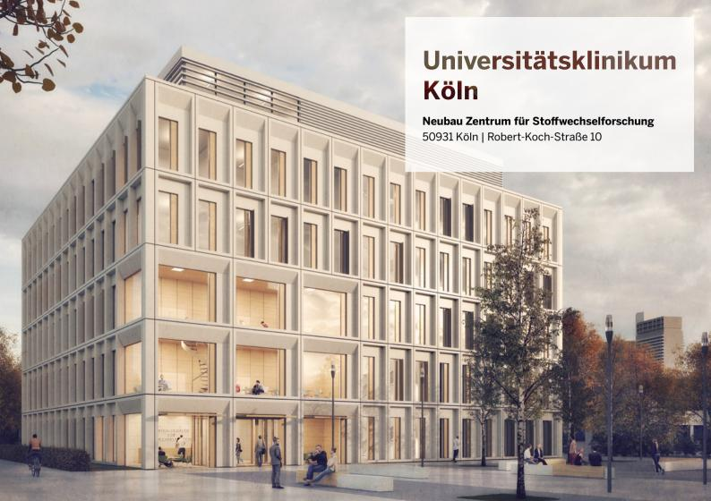
Der Neubau des Zentrums für Stoffwechselforschung entsteht auf dem bisherigen Grundstück der Experimentellen Medizin und wird als quadratischer fünfgeschossiger Baukörper von ca. 35,5 m x 35,5 m errichtet. Die Gebäudegröße richtet sich nach aufzunehmenden städtebaulichen Fluchten und Abstandsflächen und stellt eine maximale Ausnutzung des Grundstückes dar. Die Nähe zu den umliegenden Forschungslaboren sichert Synergieeffekte und baut den Life-Science-Campus aus.
