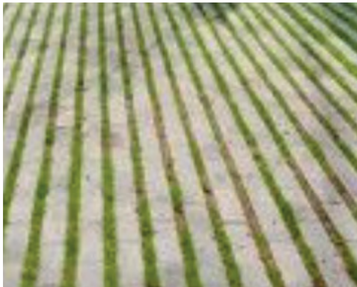
Rasenfugen für Stellplätze
