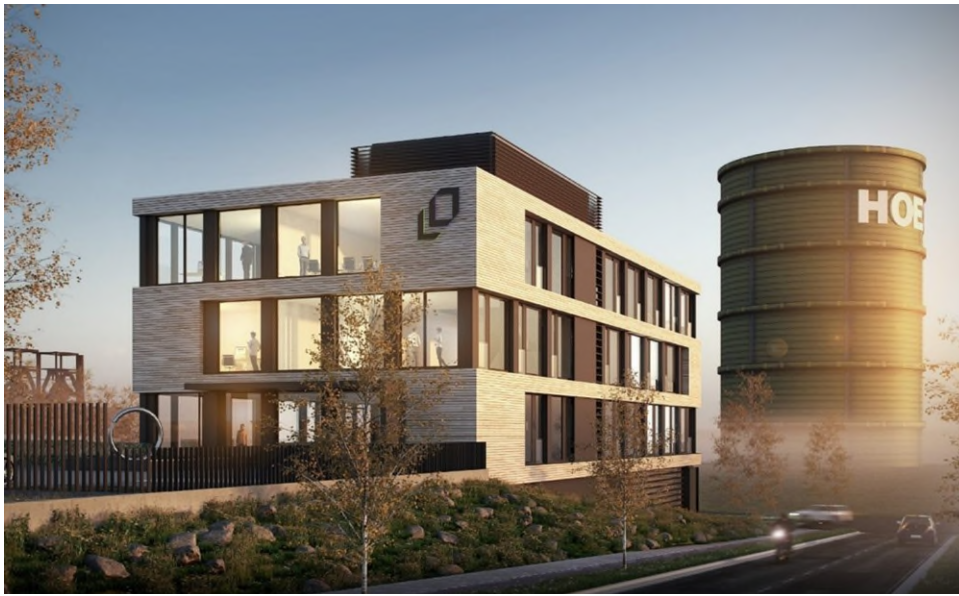
Abbildung 4: Firmengebäude Louis Opländer GmbH & Co. KG (Quelle: |DA| Drahtler Architekten)
