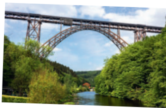
Müngstener Brücke zwischen Remscheid und Solingen
