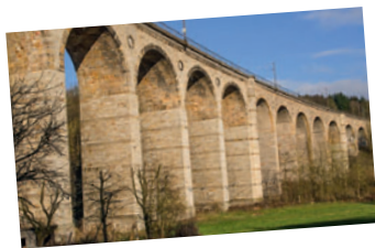
Viadukt in Altenbeken
